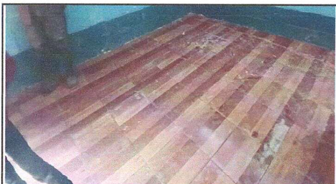
Foto 4: Piso cerámico instalado.
