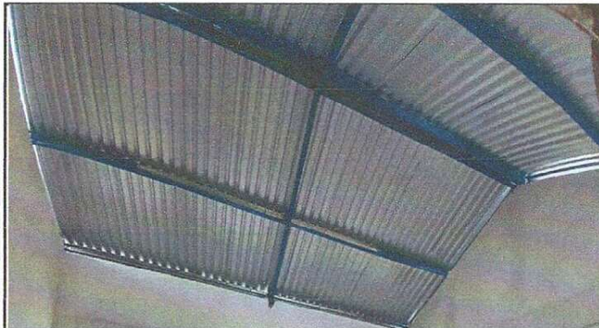
Foto 2: Constanteras instaladas.
