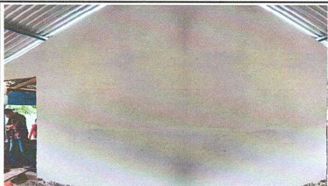
Foto1: Pared nuevo construido.
